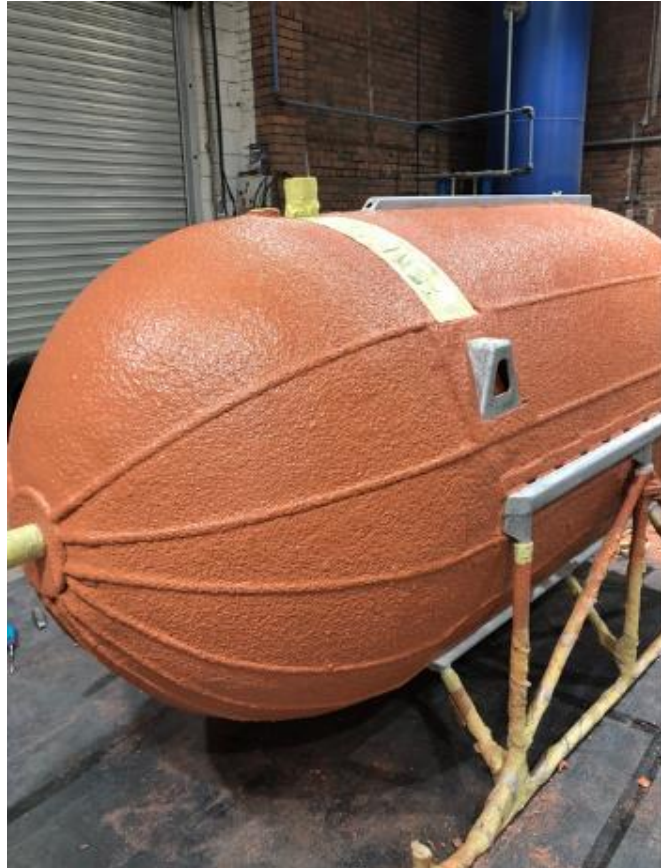
Obr. 2 Aplikácia produktu Belzona 5871 na komplikovanú plochu
