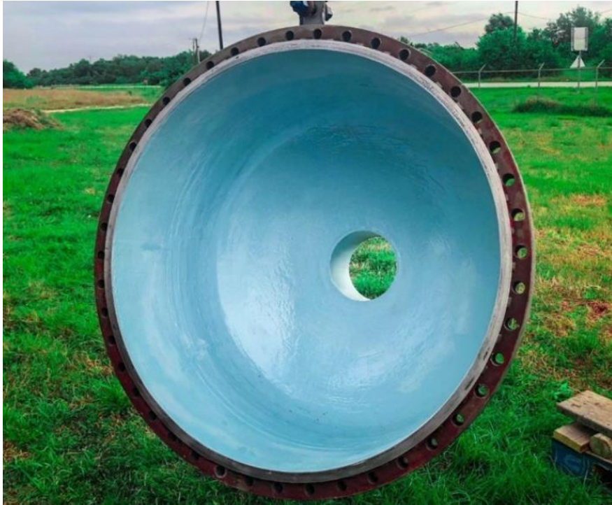
Obr. 12 Opravené veko s vnútorným náterom Belzona 1593
