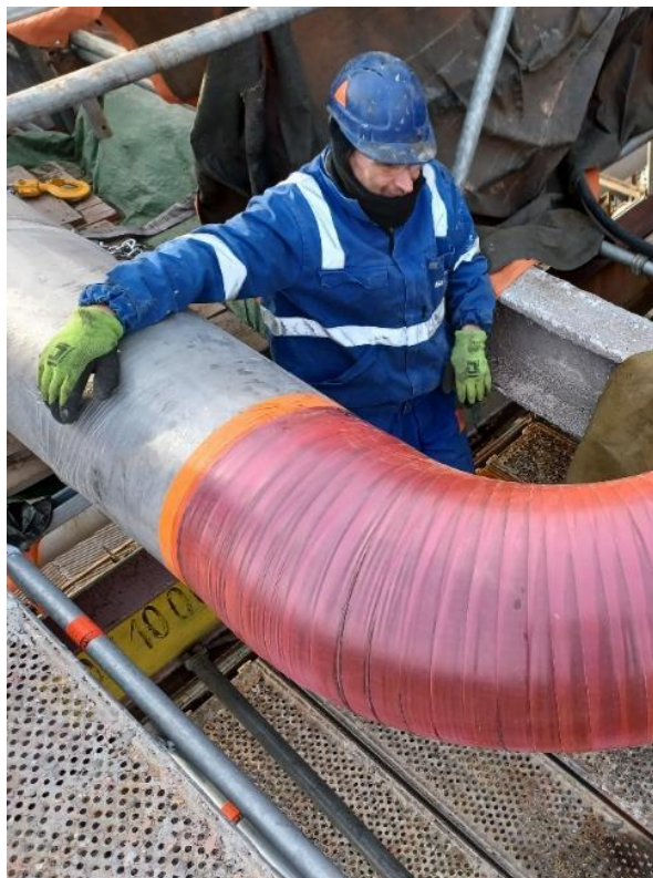
Obr. 9. Finálna podoba systému Belzona SuperWrap II
