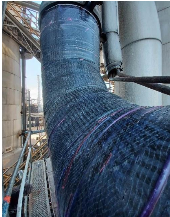
Obr. 8. Po nanesení vrstiev z uhlíkových a sklenených vlákien je potrebné, aby tieto vytvrdli pod špeciálnou umelohmotnou páskou
