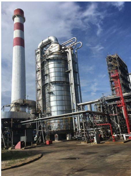
Obr.12 Pôvodná 55 ročná destilačná pec F1
