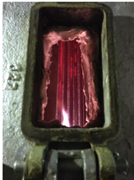
Obr.6 Fotografia rozžiarených rúr počas odkoksovania 04/2021
