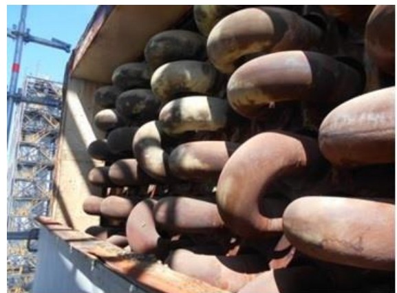
Obr.4: Fotografia z inšpekcie konvekčnej sekcie.
