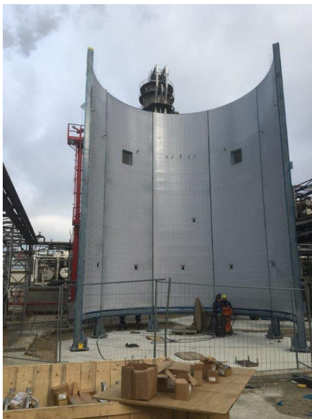
Obr. 9 Výstavba novej radiačnej časti
